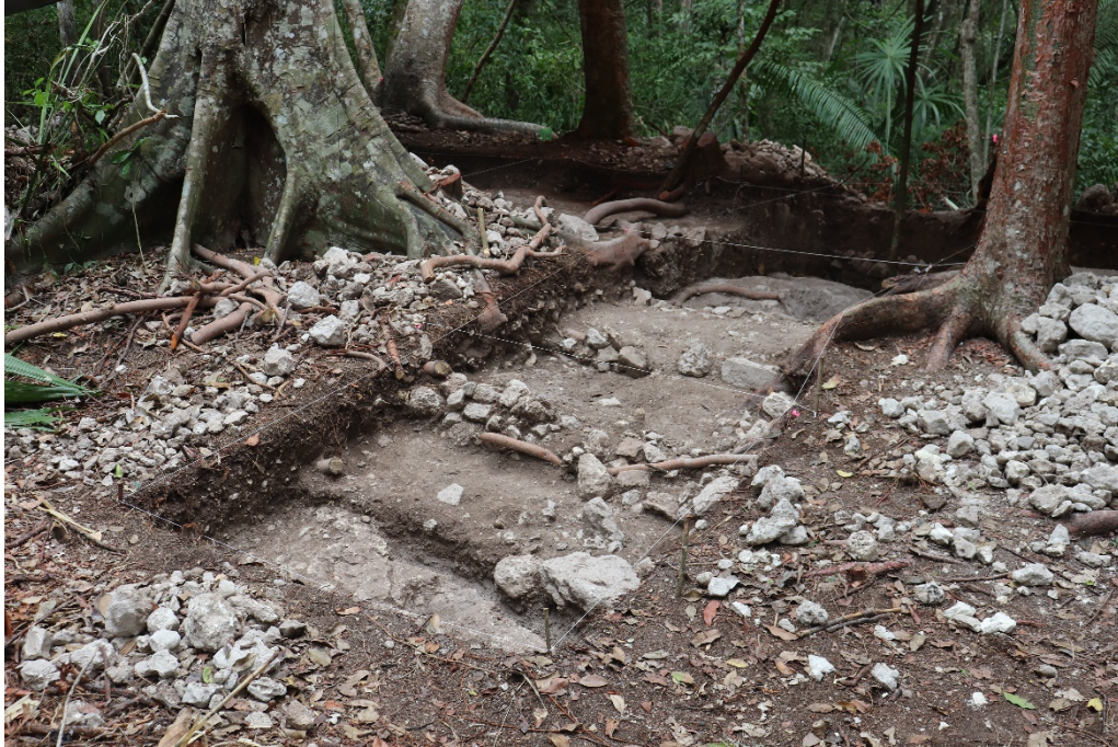
Figura 5.13. vista sureste de las unidades UCA27A-10 y UCA27A-9, Base del Nivel 2. Se observan los rasgos arquitectónicos descubiertos en ambas unidades (Fotografía M.Cano).
