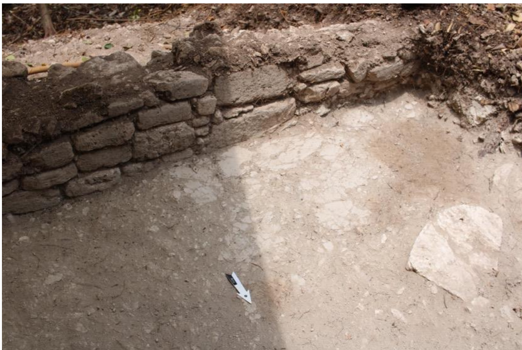
Figura 5.4 Muro, perfil sur (con vistas al sur) del interior de la superestructura A-7 (Sub-1) y su piso, Piso #1. Unidad UCA31C-15 (Foto M. Perea).
